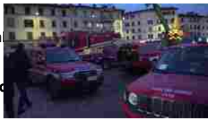
Crollo Firenze, vigili del fuoco al lavoro nel cantiere
